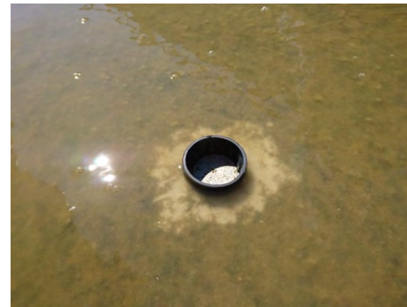
バックアップリング設置
