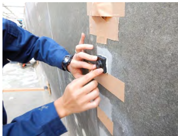
治具貼付け・養生
