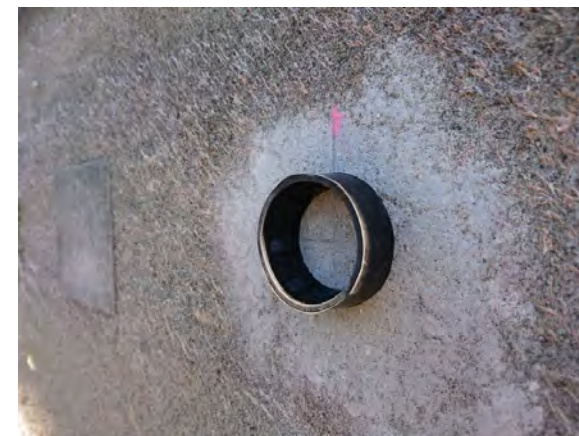
バックアップリング設置
